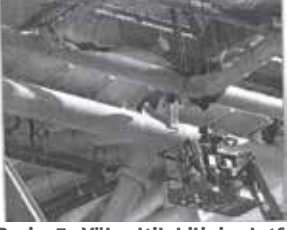
Resim 5 : Yükseltilebilir iş platformu aracılığıyla güvenlik ağı kurulumu 29- Kurulmadan Önce Ağların İncelenmesi
